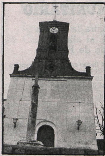
Torre de la iglesia de la Asunción, recién restaurada
