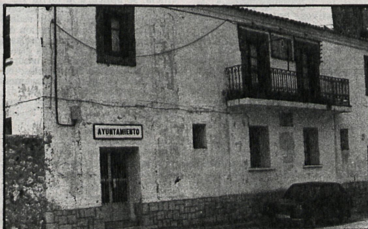
Remodelación en el Ayuntamiento de Corpa
