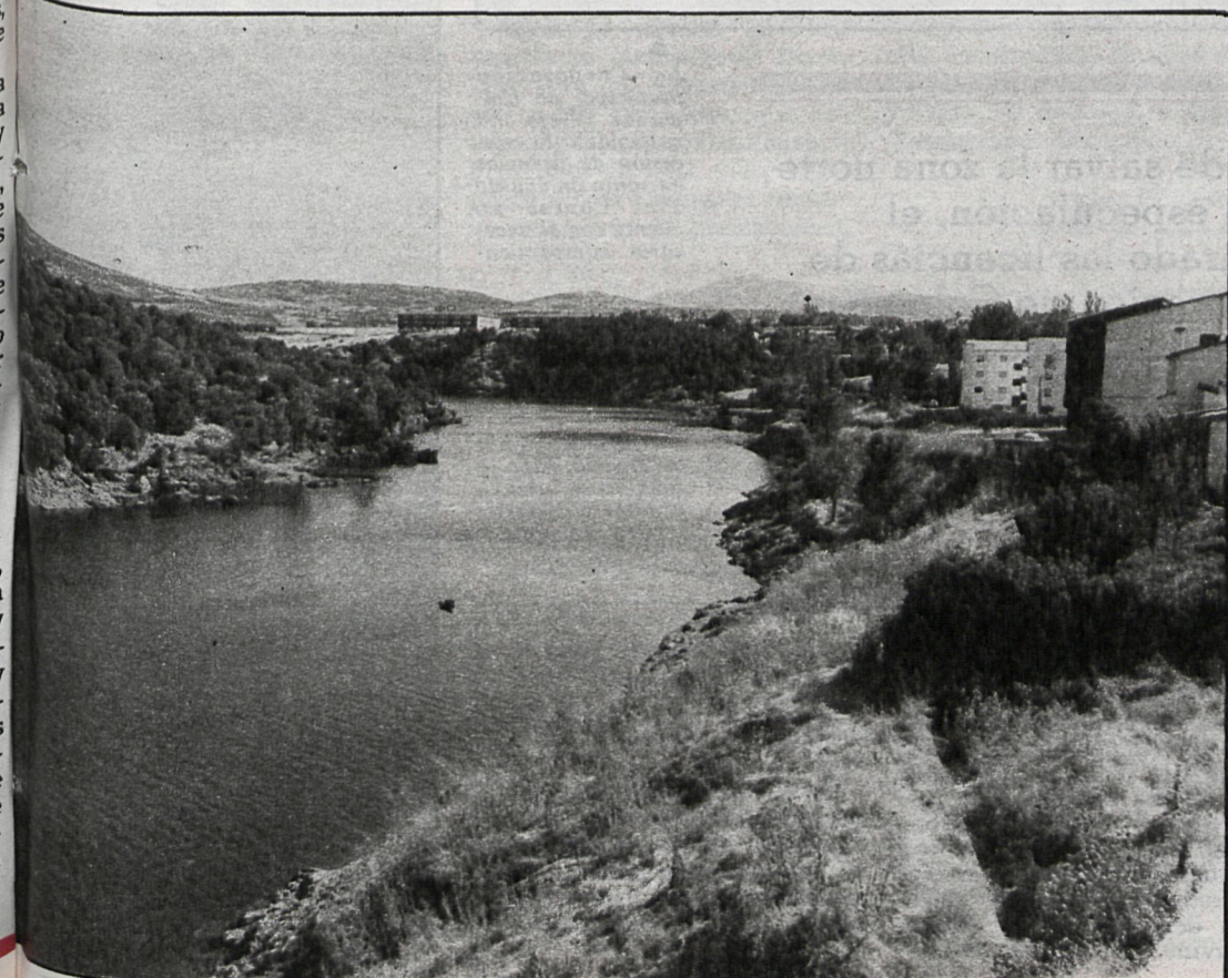
El agua se dirige hacia el embalse. Aquí ya contiene suciedades que no podrán contrarrestarse por mucha depuración que ponga en práctica el Canal de Isabel II
