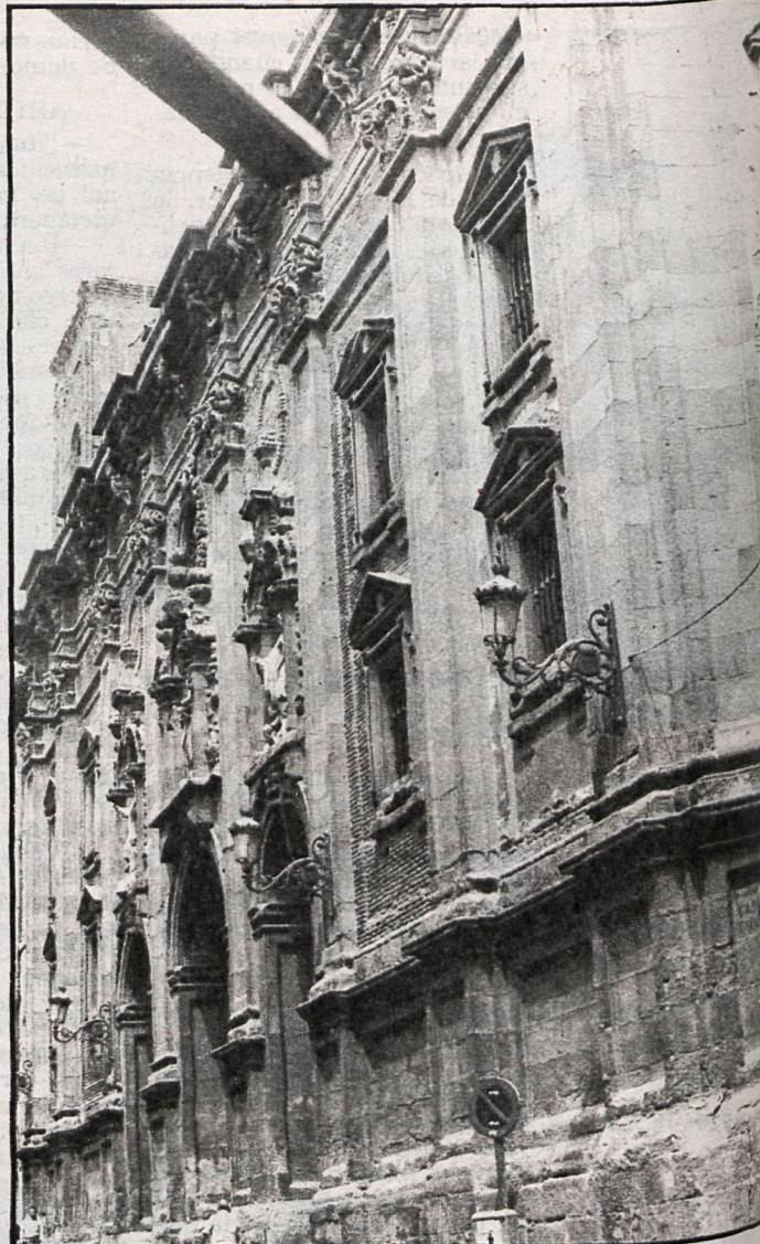
La Iglesia de San Cayetano, actualmente en remozamiento. Madrid tiene historia y sus vecinos quieren conservarla en sus monumentos, calles y plazas
