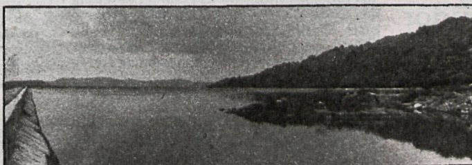
Con las obras, la presa de Soto ha aumentado notablemente su capacidad, que en estos momentos es de 750.000 metros cúbicos
