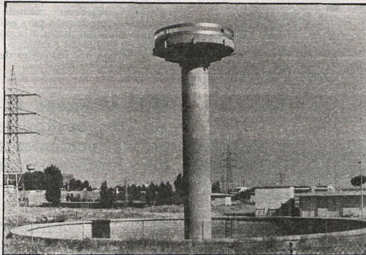
La red que suministra agua a Majadahonda está gestionada por el Canal de Isabel II, que toma la traída del preciado líquido del contaminado embalse de Valmayor
