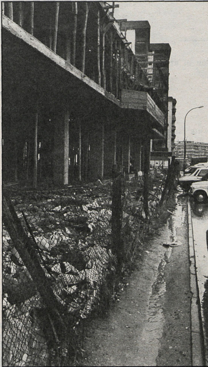
Con el convenio firmado entre Ayuntamiento y promotores se pondrá fin a las graves deficiencias del polígono 21 de Móstoles. En la foto, una vista del Parque Fátima, cuya problemática se encuentra también en vías de una solución negociada.
