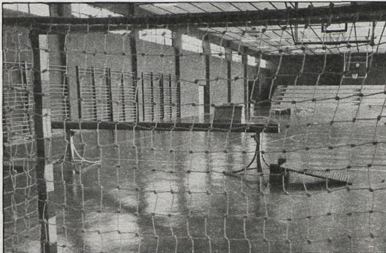
La construcción del nuevo polideportivo cubierto supone una inversión de 93 millones de pesetas
