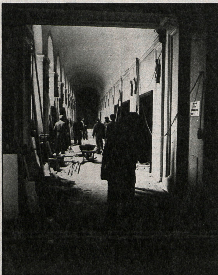
El interior del edificio de la Universidad de San Bernardo se acondiciona para el nuevo Parlamento, sin perder su estilo arquitectónico
