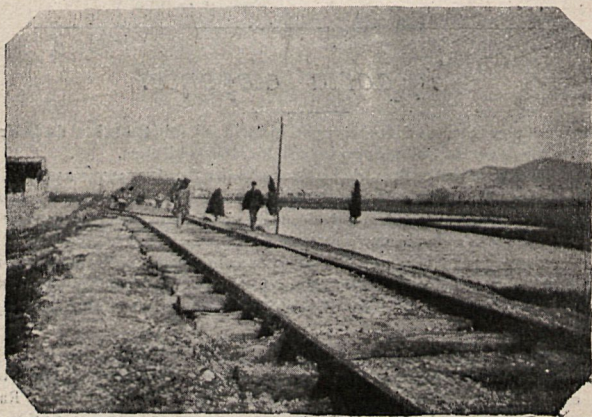
VILLENA: INUNDACIÓN DE LA VÍA FÉRREA
