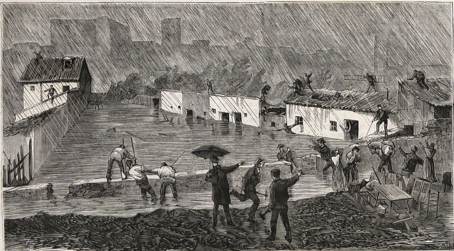
Inundacion del barrio de Chamberí.
