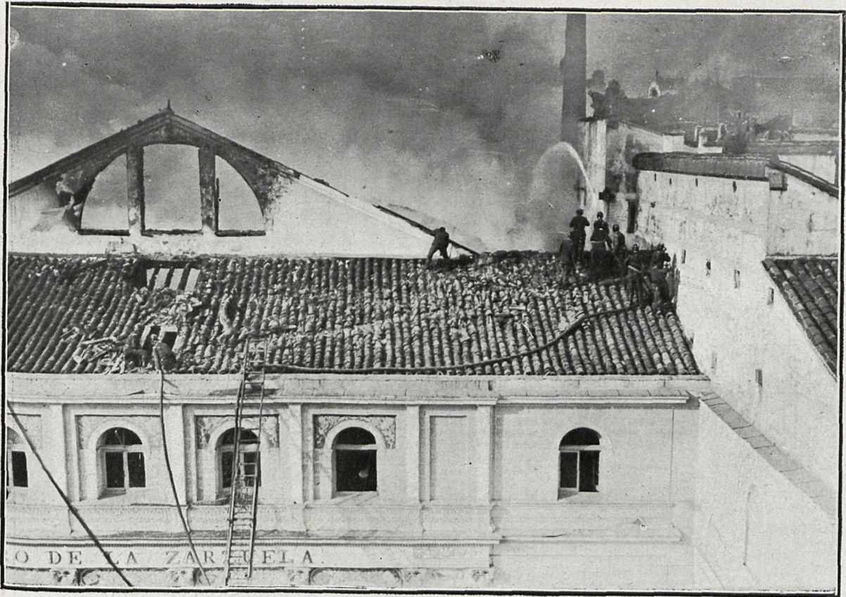
EL INCENDIO VISTO DESDE LA FACHADA PRINCIPAL
