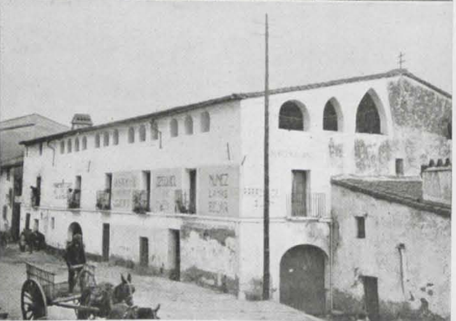
13.— RITMO DE HUECOS. SERIE ALTA DE ARQUILLOS. EN LA PLANTA BAJA NO PUEDE FALTAR EL PORTALÓN DE ARCO ANCHO. CURIOSA LA SERIE DE TRES ARCOS DISTINTOS EN LA FACHADA LATERAL, PASANDO DEL MEDIO PUNTO AL APUNTADO PARA SEGUIR LA INCLINACIÓN DEL TEJADO. EN ESTA CASA SE VE LO QUE EL ARQUITECTO SOLANA ADAPTÓ AL CARÁCTER REGIONAL EN EL PROYECTO QUE PUBLICAMOS MÁS ADELANTE (PLASENCIA. CASA DE OFICIOS DE LA CATEDRAL).
