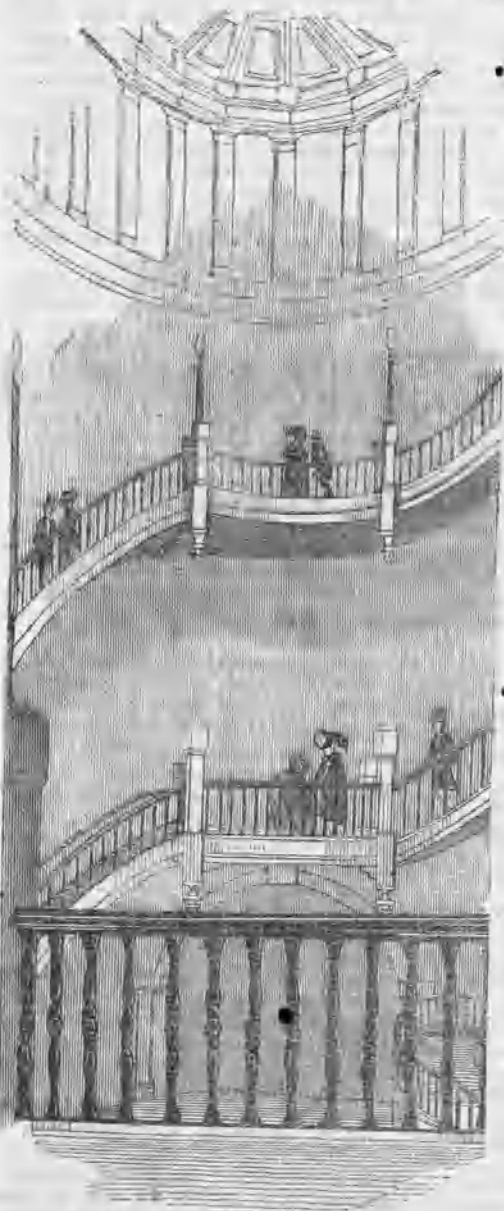
Gran escalera de bajada al tunnel.
