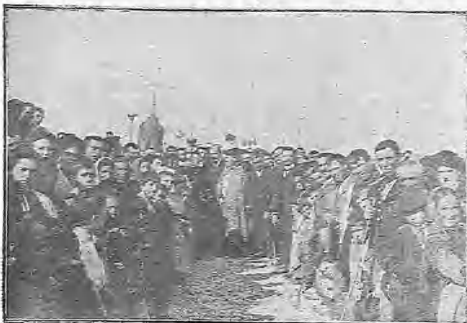
ACTO DE LA BENDICION DEL NUEVO PUENTE SOBRE EL HENARES
