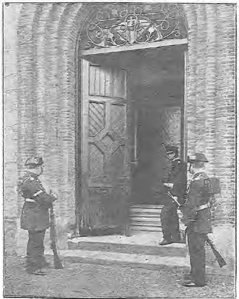
LA PUERTA DEL CONVENTO DETERIORADA POR EFECTO DE LA EXPLOSIÓN (Fots. Merletti.)
