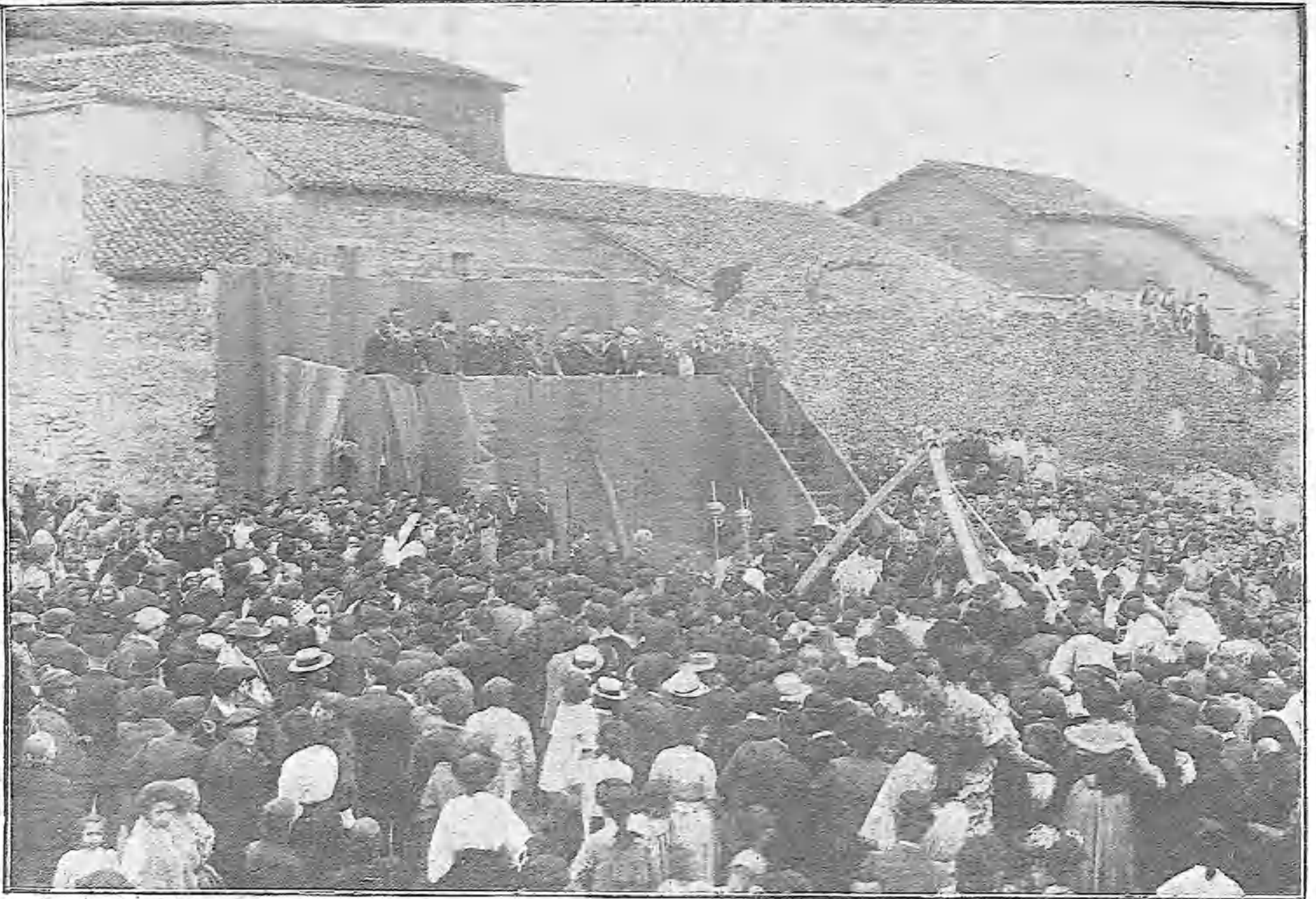
FIESTAS EN SANTO DOMINGO DE LA CALZADA.—ACTO DE COLOCAR LA PRIMERA PIEDRA PARA EL EDIFICIO DE LAS ESCUELAS MUNICIPALES
