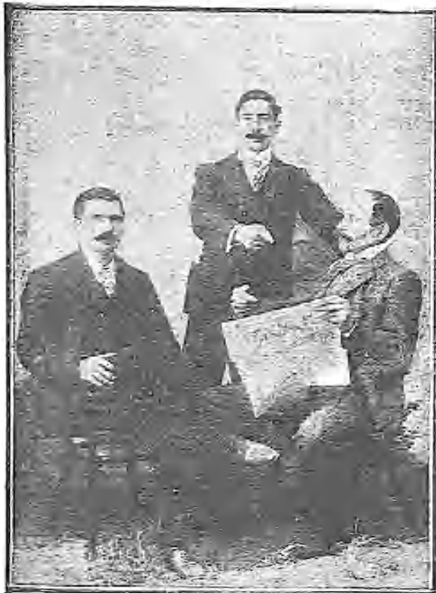
LOS OBREROS DONNAY, CRESPO Y ARANGUIZ, QUE HAN OBTENIDO EL PREMIO DE S. M. EL REY (1.000 PESETAS) POR LA CONSTRUCCIÓN DE UNA TURBINA
