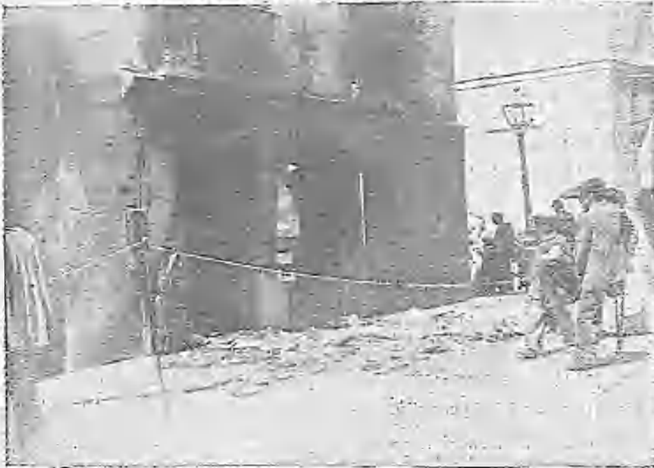
ASPECTO DE LA TIENDA ESTABLECIDA EN EL NÚM. 32 DESPUÉS DE EXTINGUIRSE EL FUEGO (Fot. Julio Rodríguez.)
