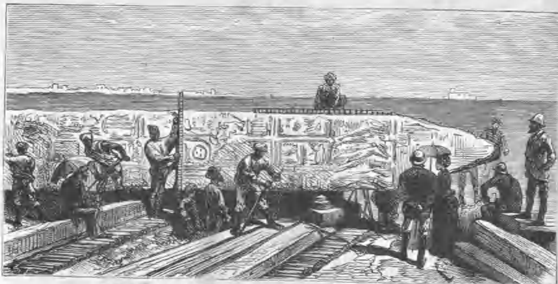
Fig. 1.ª.—Traslacion del obelisco aguja de Cleopatra para disponerlo paralelamente á la orilla.
