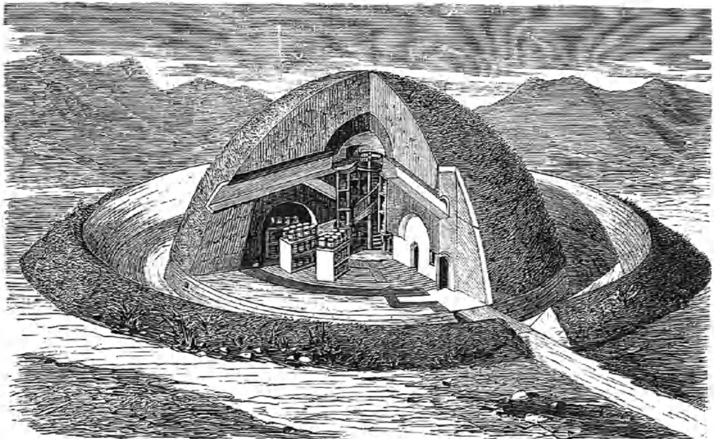
INTERIOR DE UN ALMACEN DE PÓLVORA.
