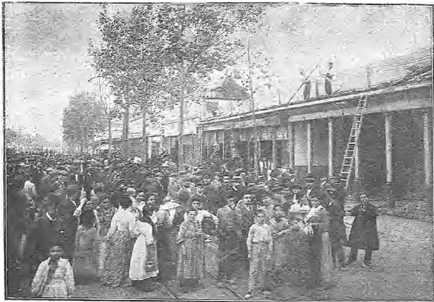
DEMOLICIÓN DE LAS CONSTRUCCIONES DE LA RASANTE ILEGAL
