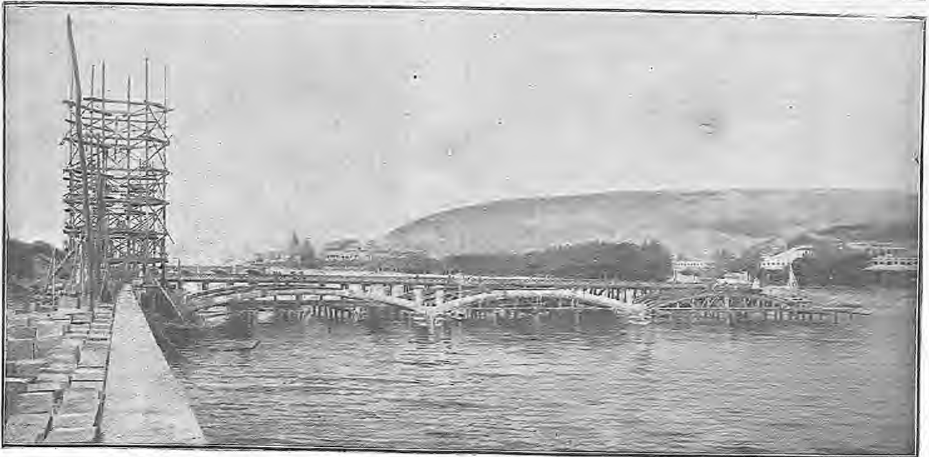
ESTADO ACTUAL DE LAS OBRAS DEL PUENTE SOBRE EL URUMEA, QUE QUEDARA TERMINADO EN OCTUBRE
