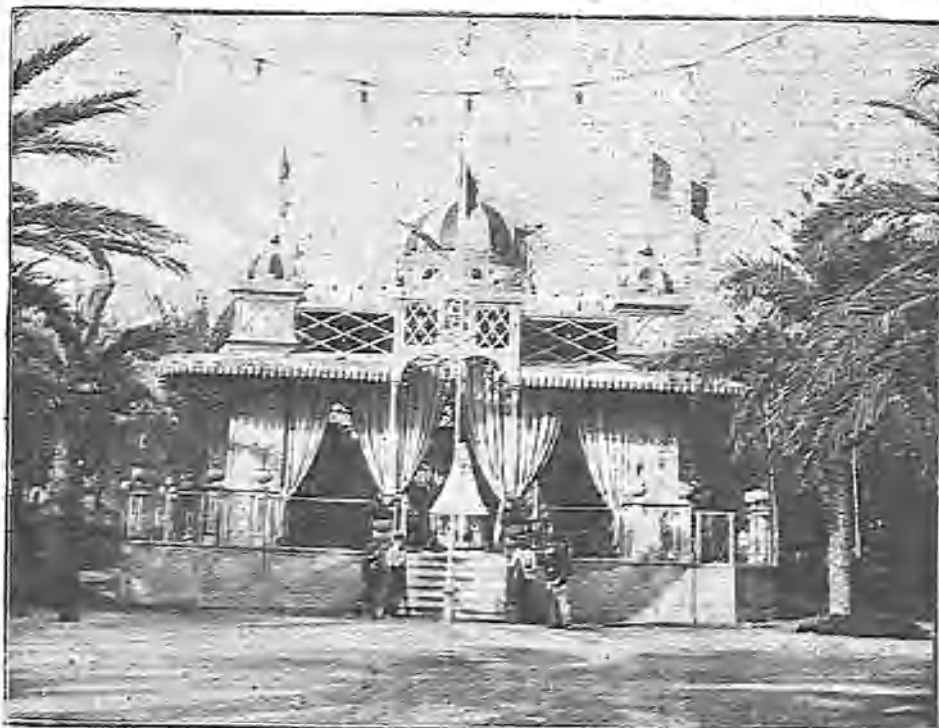
PABELLÓN DEL CASINO GADITANO
