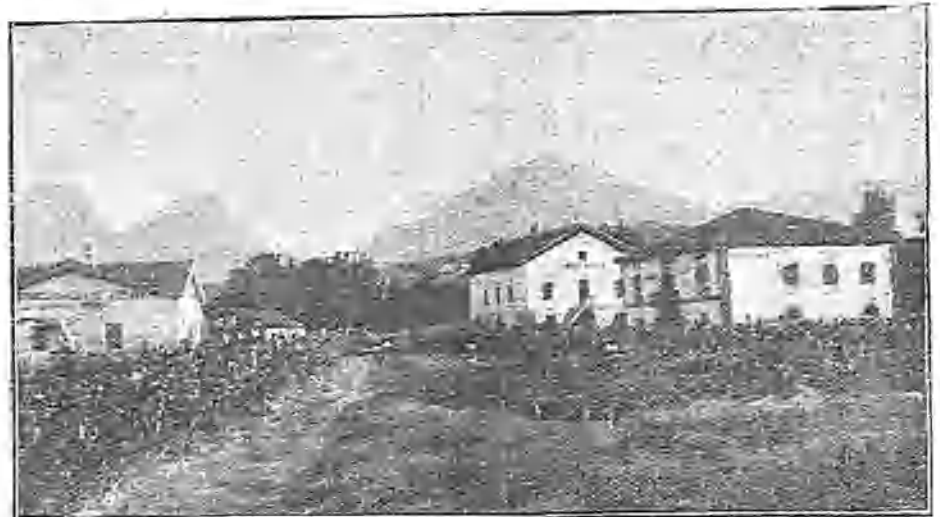
VISTA GENERAL DE LOS EDIFICIOS QUE CONSTITUYEN LA GRANJA AGRÍCOLA
