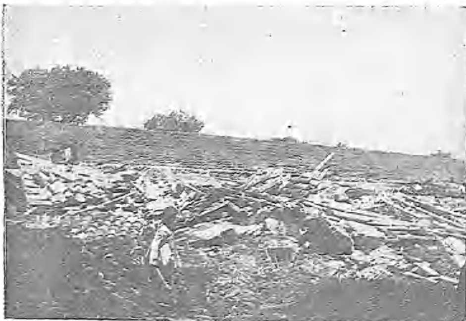
CASAS DERRUMBADAS EN LA CALLE DEL INIENTO COLGANTE
