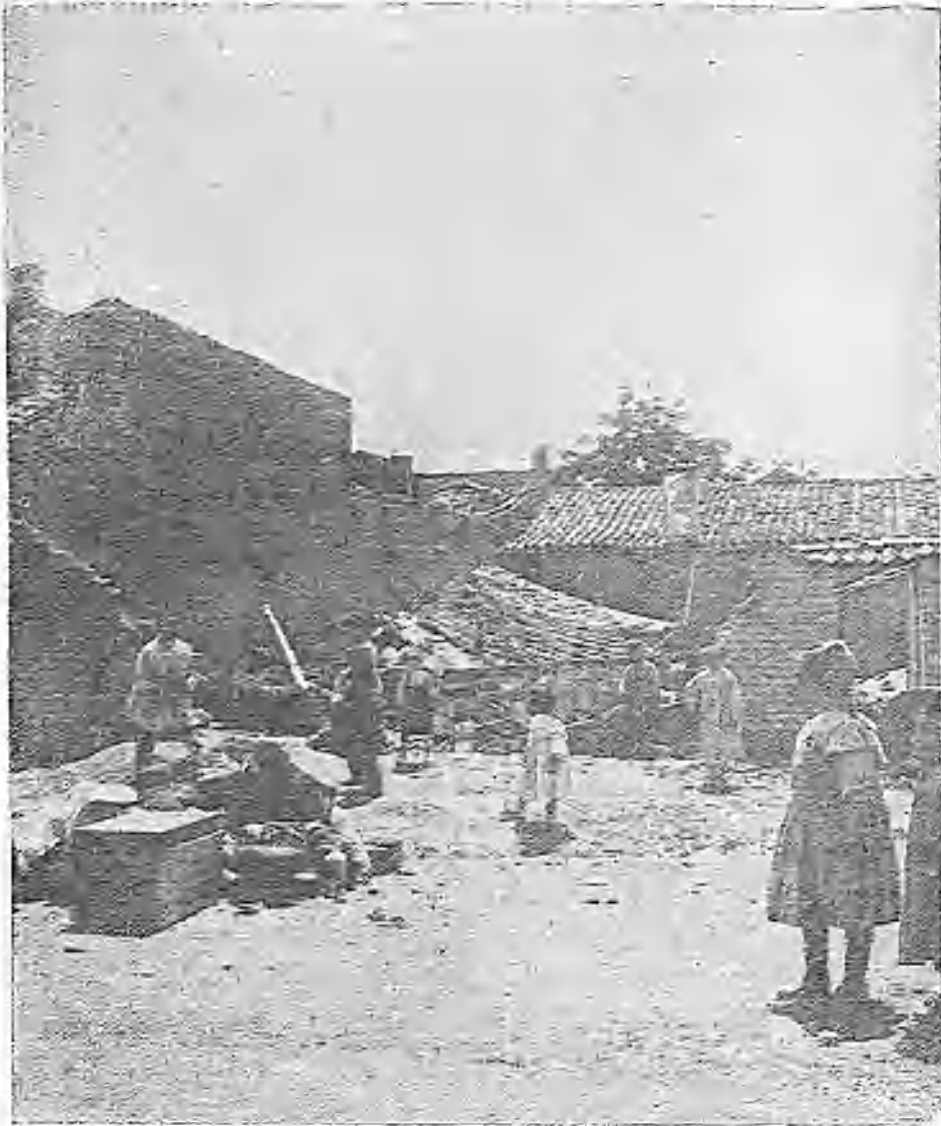
CASA DERRUMBADA EN EL BARRIO DE LOS VADILLOS. EN PRIMER TÉRMINO, Y Á LA IZQUIERDA, SE VEN AMONTONADOS ALGUNOS EFECTOS DE LOS QUE COMPONIAN LOS MISEROS AJUARES DE LOS INUNDADOS
