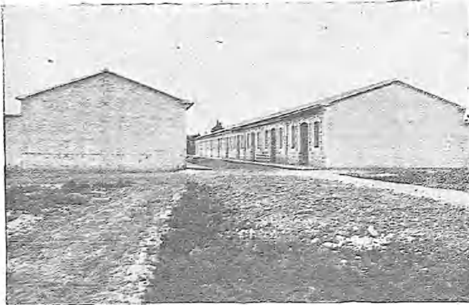
GRUPO DE CASAS HECHAS POR LA SOCIEDAD CONSTRUCTORA DE VALENCIA. LLEVA EDIFICADAS VEINTE SEIS EN LA CALLE DEL LIRIO DEL GRAO Y CATORCE EN LA DEL GENERAL PANDO. OTRAS SEIS ESTÁN CONSTRUYÉNDOSE EN ESTE ÚLTIMO LUGAR
