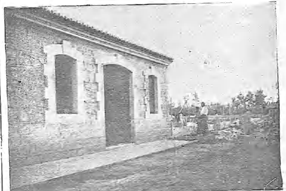
VISTA DE UNA CASA Y CONTINUACIÓN DE LAS OBRAS. LOS OBREROS PASAN DE ARRENDATARIOS Á PROPIETARIOS DE LAS VIVIENDAS, PASADO CIERTO NÚMERO DE AÑOS, CON SÓLO SATISFACER UNA PEQUEÑA CUOTA DE ALQUILER MENSUAL
