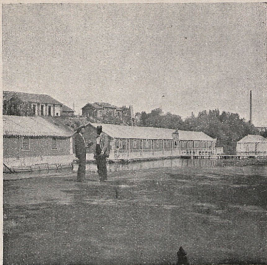
VALLADOLID: BAÑOS EN EL PISUERGA Inst. de P. Muñoz.
