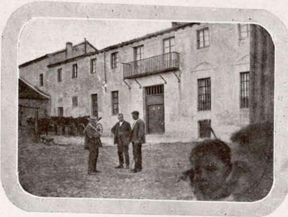
Fachada del Palacio donde se ha instalado la colonia.
