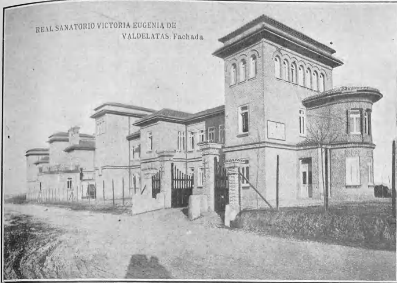
Real Sanatorio Victoria Eugenia de Valdelatas. Fachada principal
