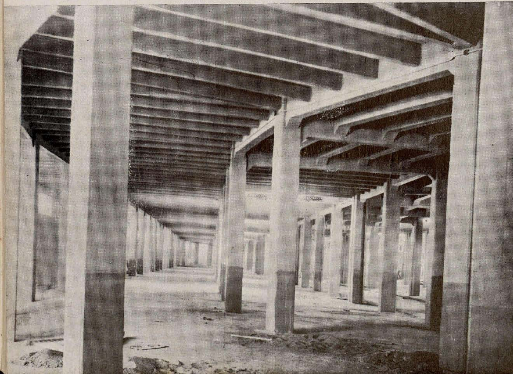
Una vista de la nave de planta baja del nuevo Mercado de Frutas y Verduras, que ya está en servicio.
