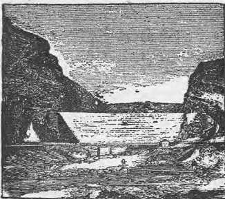
Presa del Pontón de la Oliva.
