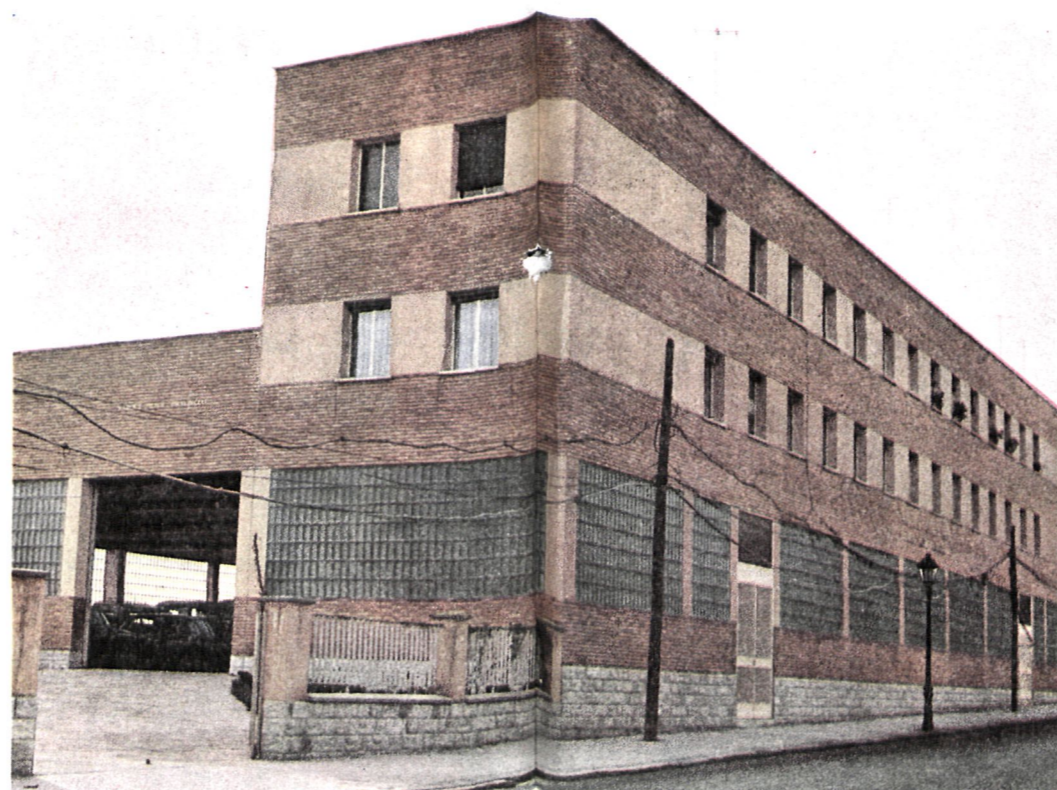
Parque Móvil Provincial. Terminado y en funcionamiento.
