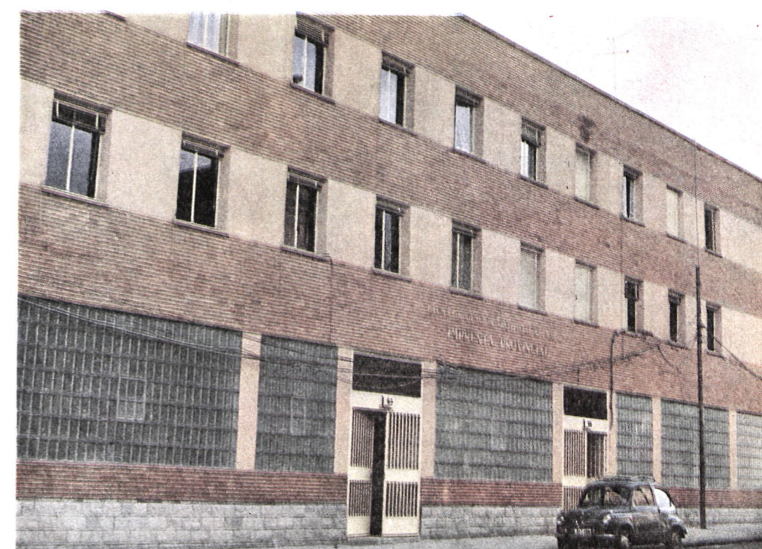
Imprenta Provincial. Edificio terminado y en funcionamiento.
