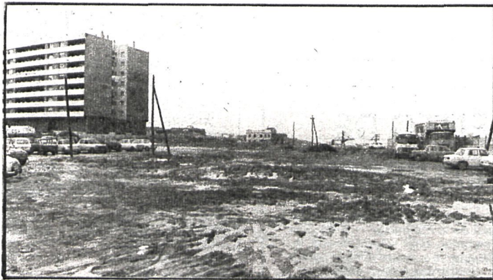
Barrizales, aparcamientos impunes y deterioro del medio ambiente: así se construyó, y eso es lo que el Ayuntamiento de Madrid va a impedir, mal que les pese a muchos que ponen su negocio por encima del bien de la comunidad
