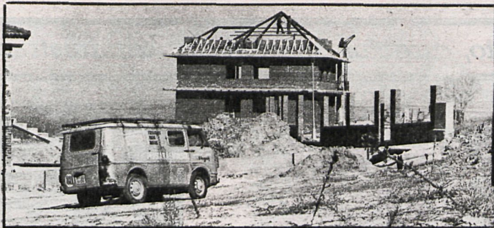
Pese al expediente, los constructores siguen con las obras
