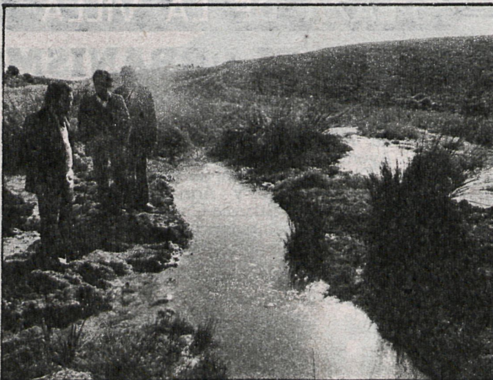
Las fugas de agua de la red, a consecuencia de las roturas, están a la orden del día en Villarejo. La foto capta una de ellas
