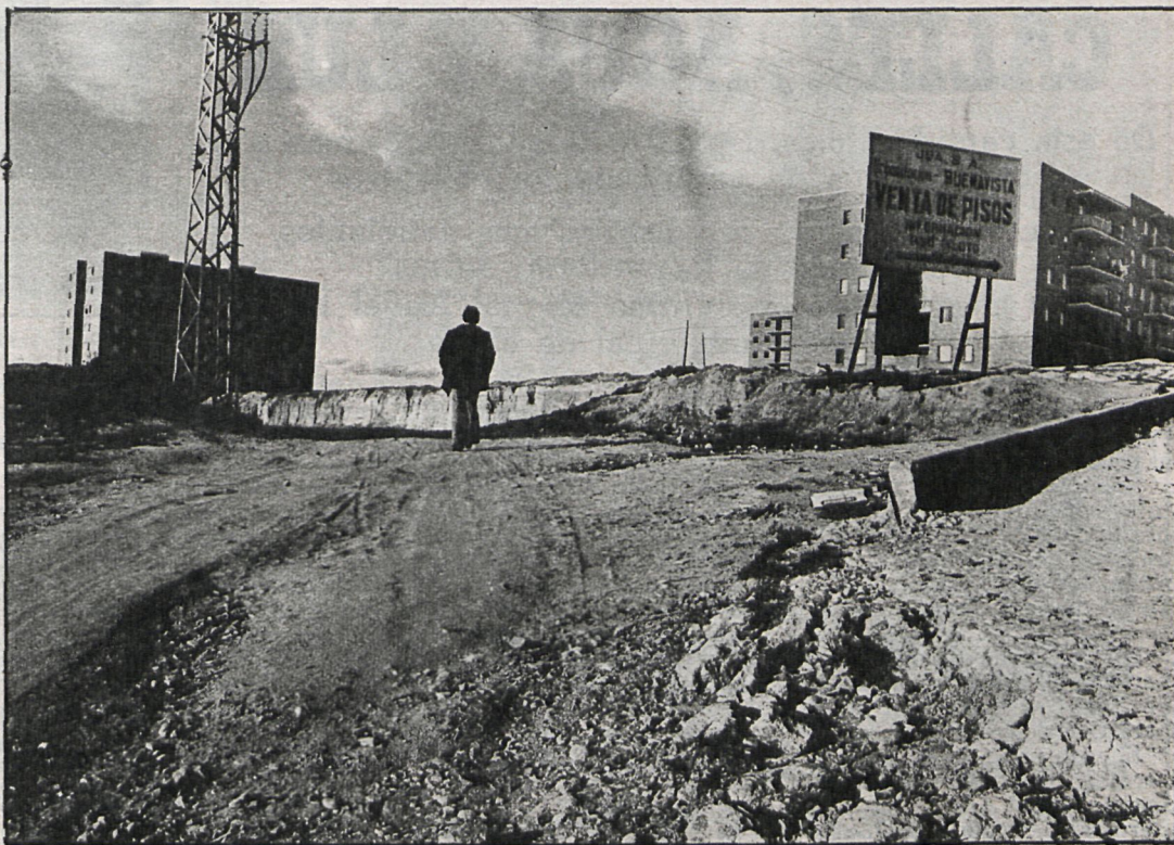
Las calles, sin pavimentar, dan un aspecto desolador a la urbanización Buenavista
