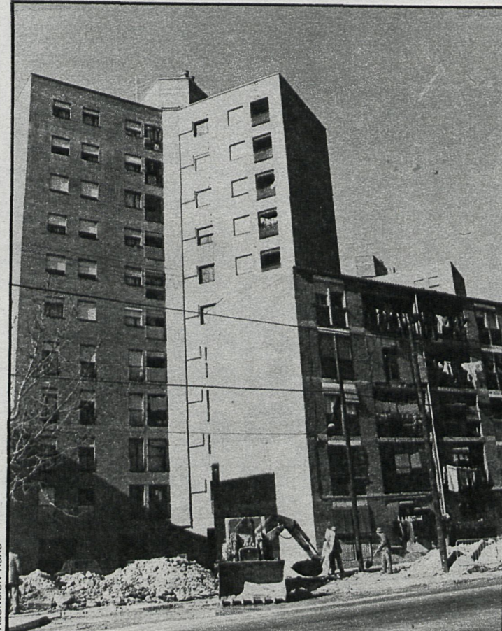
Al fondo, la vivienda-tipo construida según el plan, y que viene a sustituir a las más antiguas y deficientes de distintos barrios madrileños
