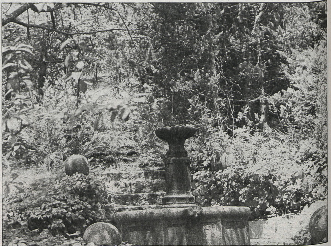
El exterior del convento de San Julián y San Antonio presenta un aspecto deplorable, con la escalera totalmente cubierta de matorrales
