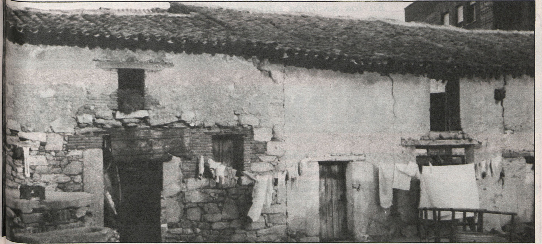
En algunas zonas, el deterioro de las viviendas es patente
