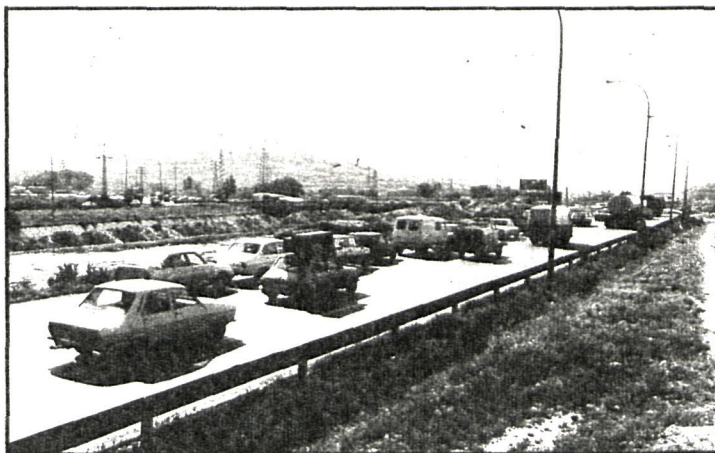
Las obras del nudo sur permitirán el acceso a la M-30 desde la carretera de Andalucía
