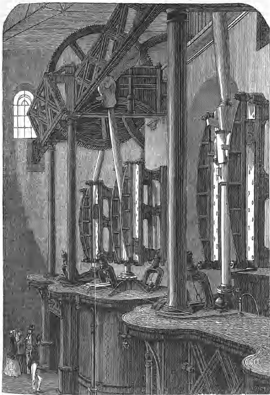
BOMBAS PARA EXTRAER EL AIRE DEL TUNEL DEL CAMINO DE HIERRO ATMOSFÉRICO DE SAINT-GERMAIN.
