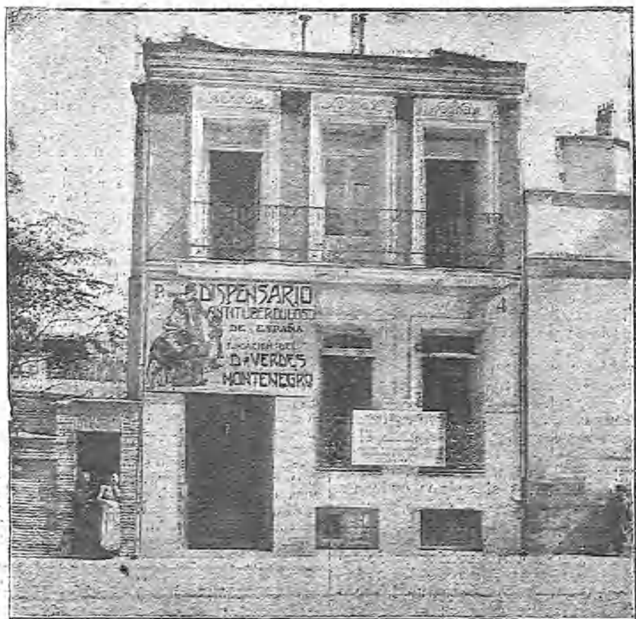
EDIFICIO DEL DISPENSARIO ANTITUBERCULOSO DE MADRID
