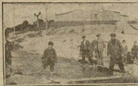
Peligroso tablón para vadear el arroyo Abroñigal, que arrastrado por las aguas durante la tormenta del día 21 del actual, incomunicó a estos vecindarios.
