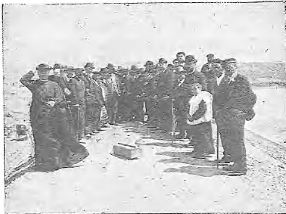
GRUPO DE AUTORIDADES Y COMISIÓN RECEPTORA DE LAS OBRAS
