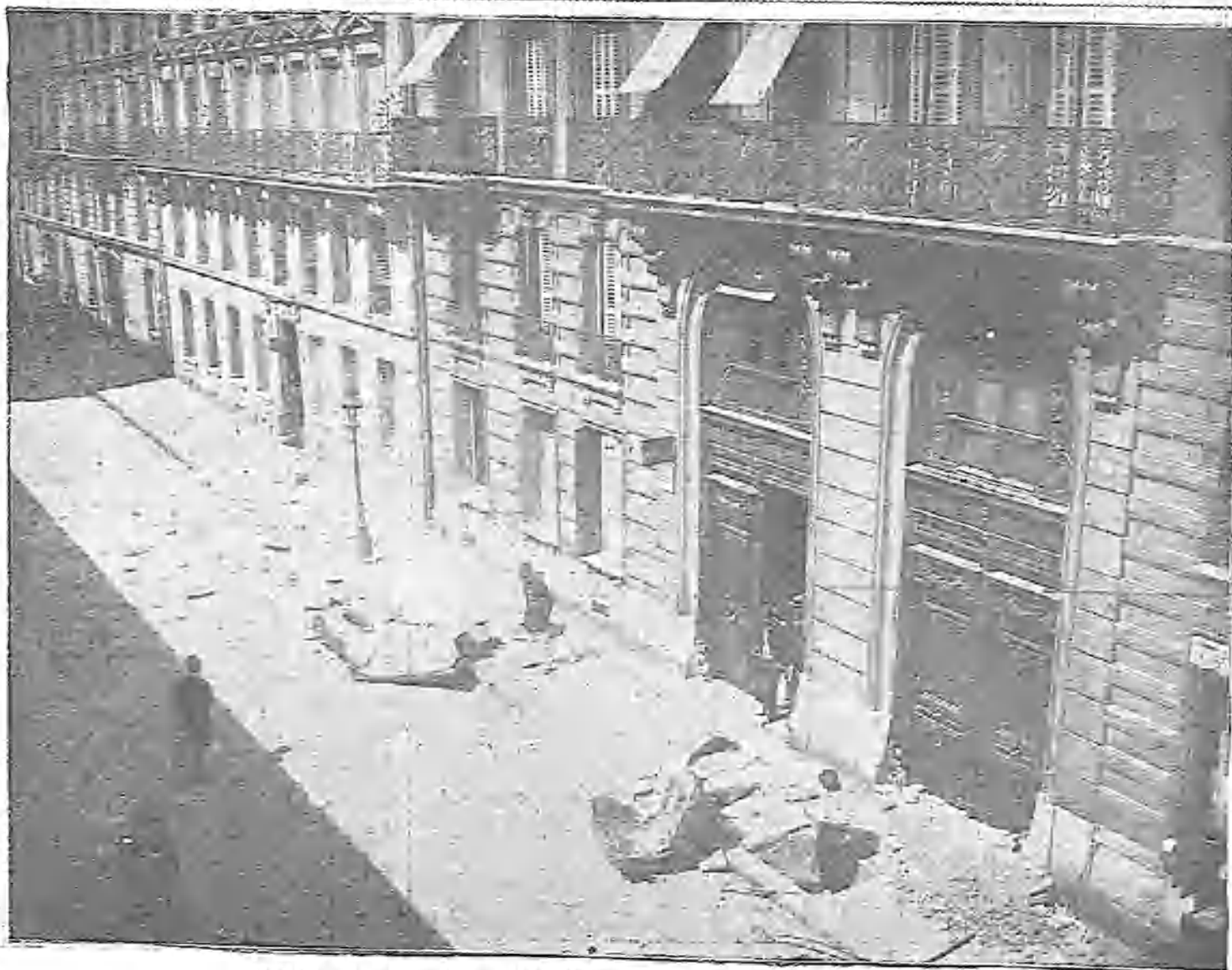
TRONCOS DE LA CALDERA QUE LLEGARON Á LA CALLE BERNA, PRÓXIMA Á LA ESTACIÓN
